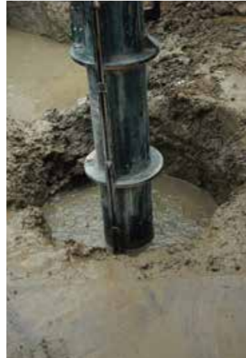
(a)掘削孔に装置挿入
