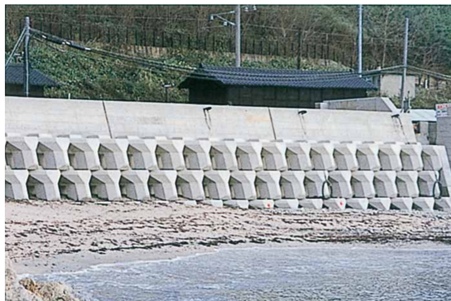
新潟県村上土木事務所・国道 345 号道路改良事業 (4ton)
