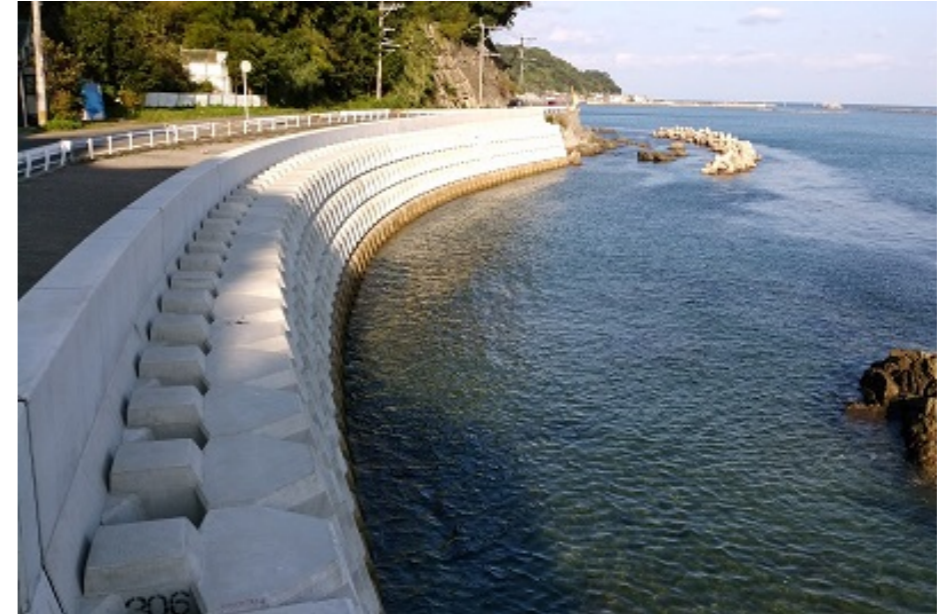
新潟県村上土木事務所・国道345号道路改良事業 (4ton)
