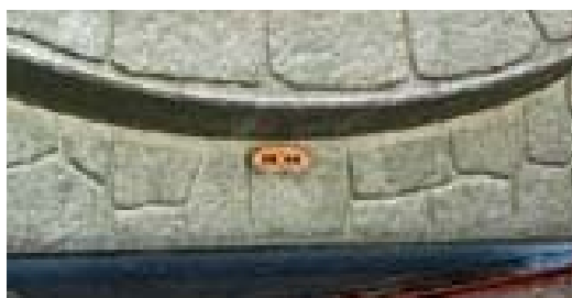
側枠A脱型後状況
