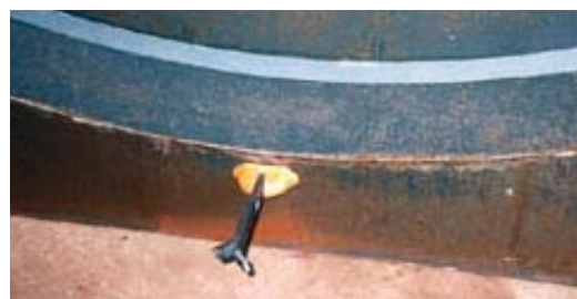
側枠A内側取付状況
