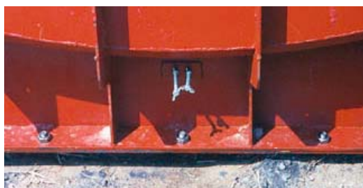
側枠A外側取付状況
