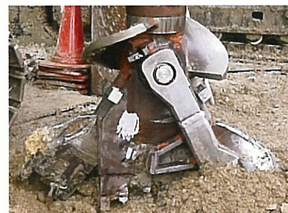
〔根固め部掘削・築造時〕
