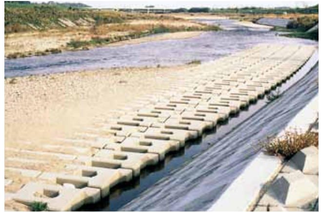
根固工 三重県鈴鹿土木事務所 安楽川災害復旧工事 サーフブロック4TON型
