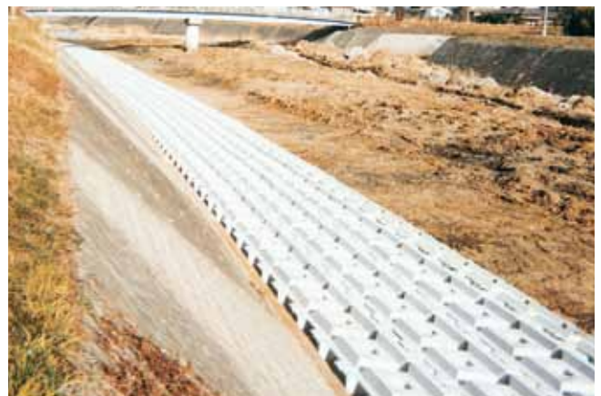
根固工 大分県大分土木事務所 円生川災害復旧工事 サーフブロック2TON型
