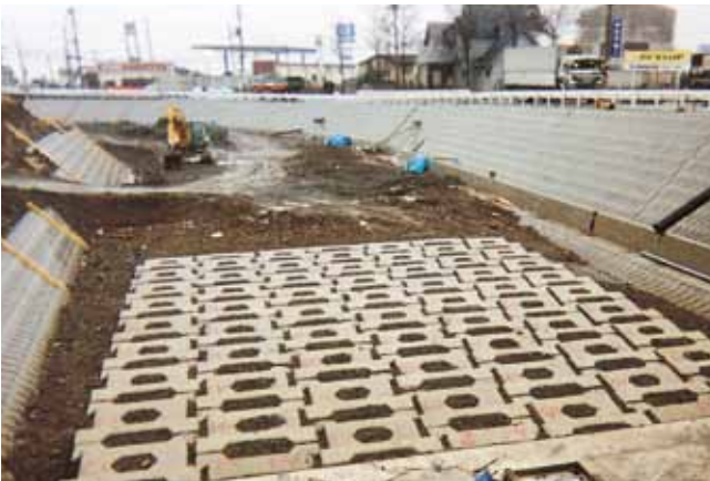
護床工 山梨県菲崎土木事務所 割羽沢川河川改修工事 サーフブロック3TON型
