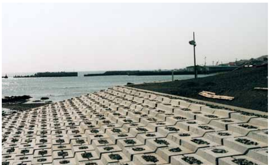
緩傾斜護岸 北海道室蘭土木現業所 えりも海岸えりも岬地区局部改良工事 サーフブロック3TON型 2割勾配にて施工
