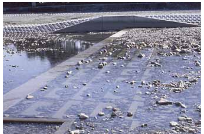
護床工 栃木県鹿沼土木事務所 黒川河川改修工事 サーフブロック4TON型
