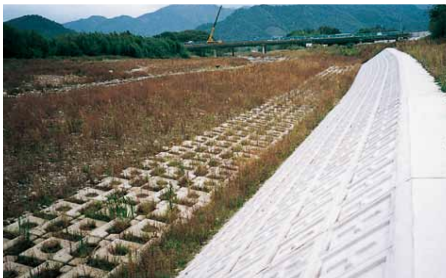
根固工 滋賀県彦根土木事務所 犬上川災害復旧工事 サーフブロック3TON型
