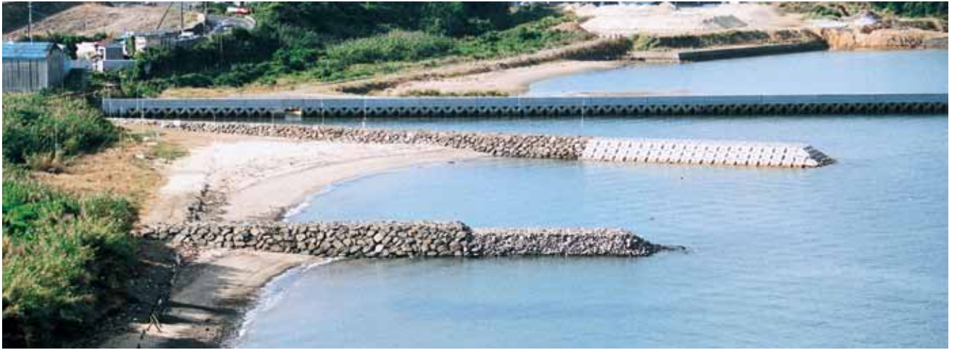
被覆工（突堤工法）長崎県田平土木事務所 調川港海岸局改良工事 サーフブロック2TON型
