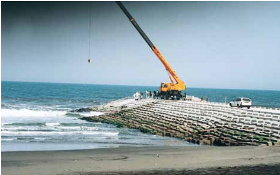
被覆工（突堤工法） 千葉県長生土木事務所 一宮海岸浸食対策工事（8号ヘッド） サーフブロック3TON型
