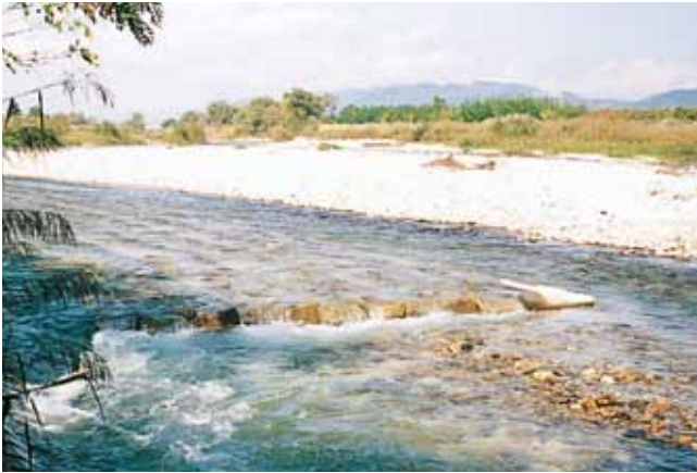
根固工 長野県豊科建設事務所 穂高川国補河川修繕工事 サーフブロック5TON型
