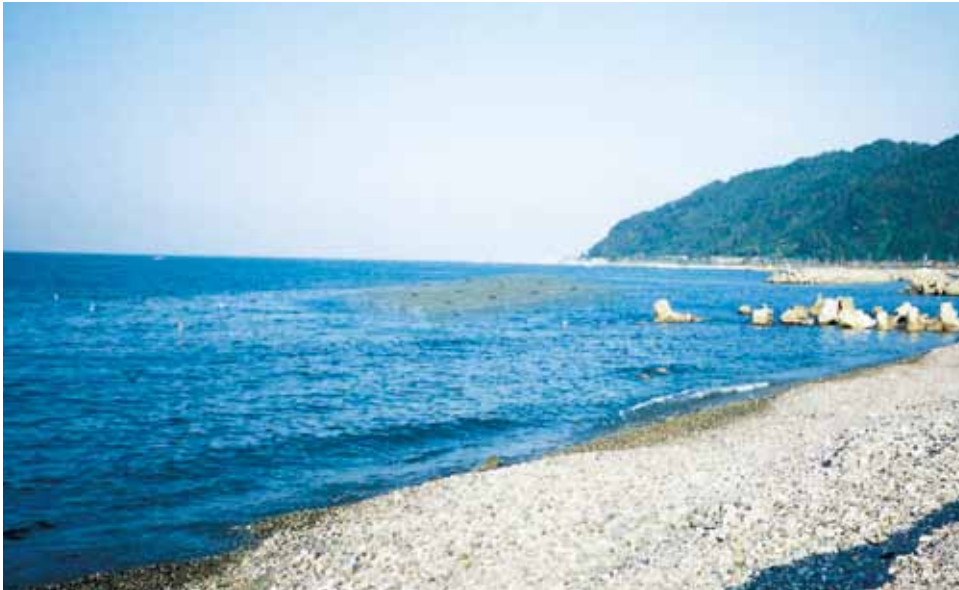
人工リーフ工法 富山県入善土木事務所 大屋海岸浸食対策工事 サーフブロック4TON型
