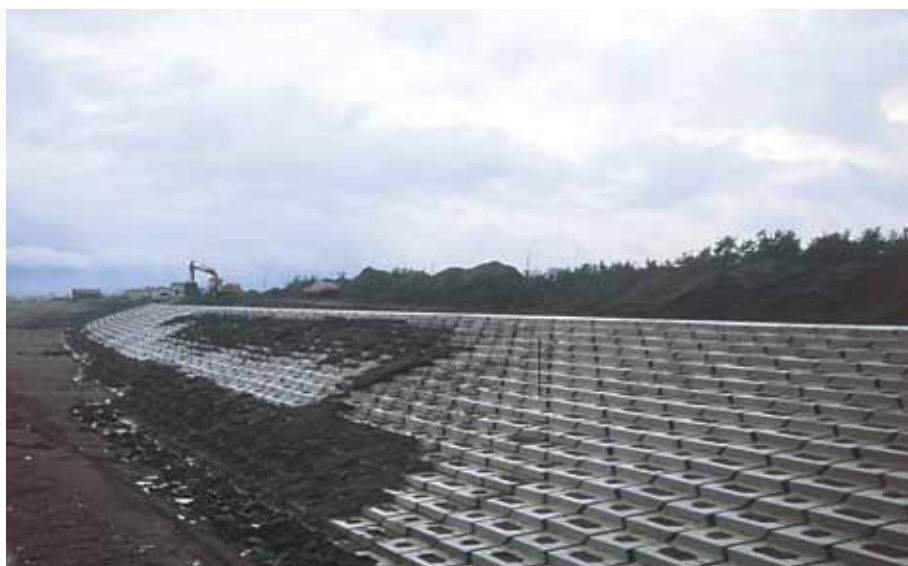
緩傾斜護岸 北海道開発局函館開発建設部 木古内町木古内道路改良工事 (木古内地区海岸) サーフブロック2TON型 3割勾配にて施工
