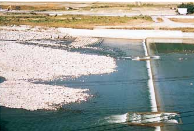
護床工 福井県福井耕地事務所 ため池等整備事業(九頭竜川上志比) サーフブロック4TON型
