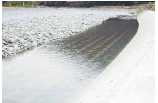
根固工 岐阜県揖斐土木事務所 根尾川災害復旧工事 サーフブロック5TON型
