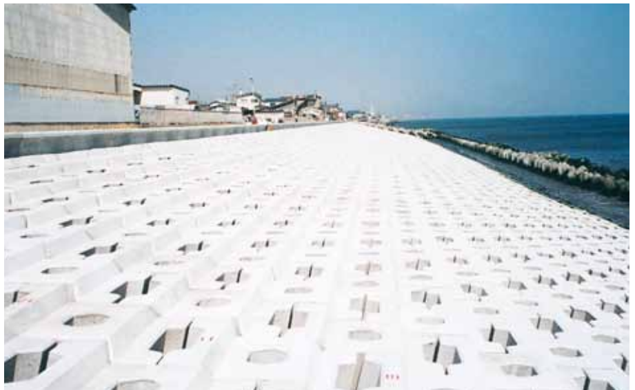
緩傾斜護岸 北海道室蘭土木現業所 登別海岸鷺別地区局部改良工事 サーフブロック2TON型 4割勾配にて施工
