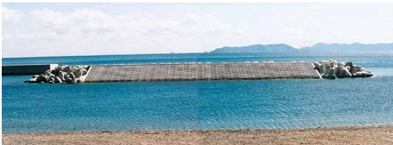
離岸堤（階段工）大分県上浦町役場 福泊漁港海岸保全（高潮対策）工事 サーフブロック4TON型
