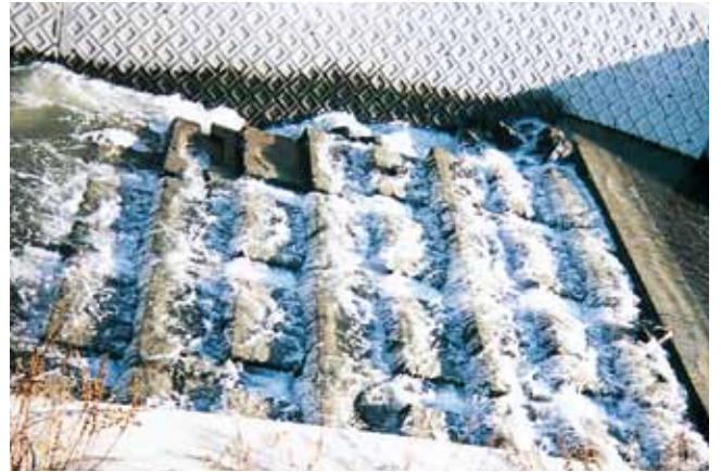
護床工 静岡県沼津土木事務所 馬伏川障害防止対策事業 サーフブロック5TON型
