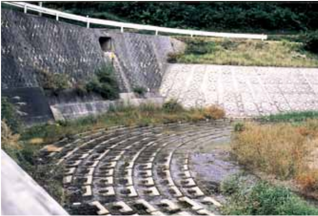
根固工 三重県伊勢土木事務所 伊勢路川災害関連工事 サーフブロック2TON型
