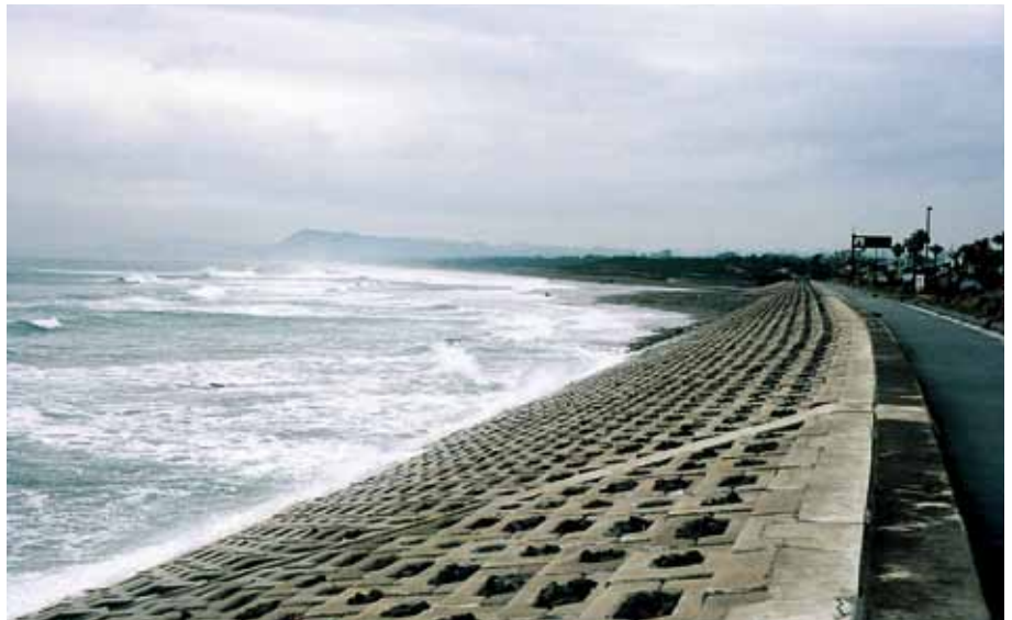
緩傾斜護岸 千葉県鴨川土木事務所 和田白渚海岸高潮対策工事 サーフブロック2TON型 3割勾配にて施工
