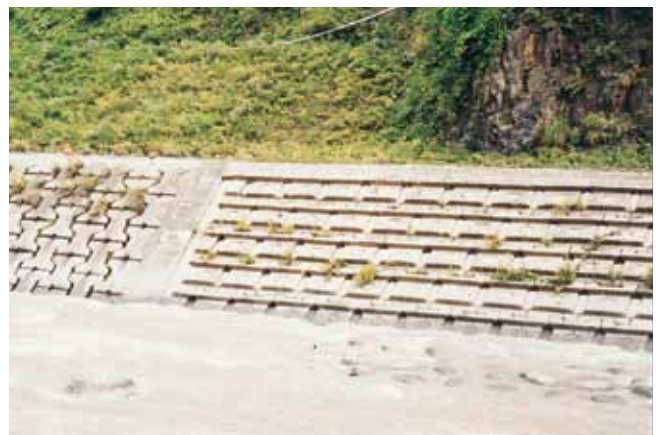
根固工 新潟県糸魚川土木事務所 平成7年度災姫川河川災害復旧工事 サーフブロック8TON型
