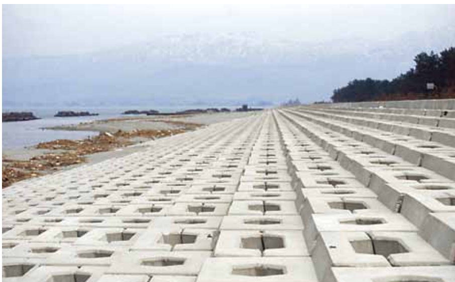
緩傾斜護岸 富山県富山土木事務所 富山海岸侵食対策工事 サーフブロック2TON型 5割勾配にて施工
