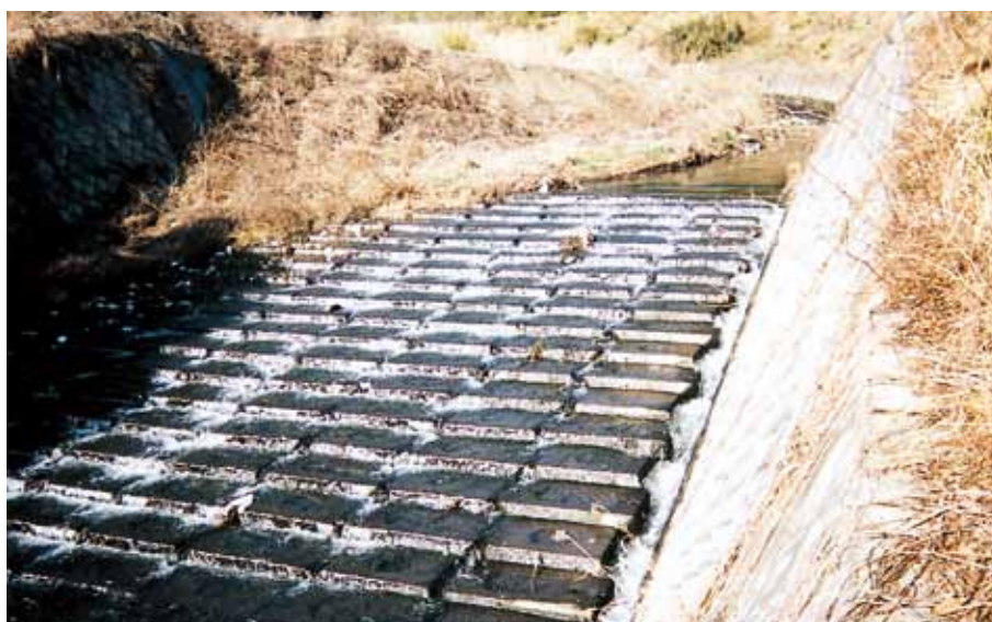
護床工 静岡県富士土木事務所 足取川河川改良工事 サーフブロック2TON型
