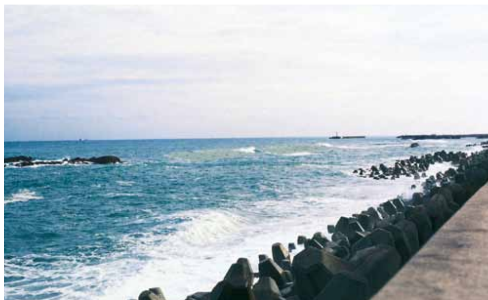
人工リーフ工法 三重県熊野土木事務所 井田地区海岸災害復旧工事 サーフブロック12TON型
