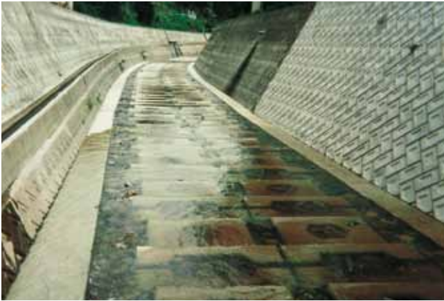
根固工 山梨県葦崎土木事務所 六反川河川災害復旧工事 サーフブロック2TON型
