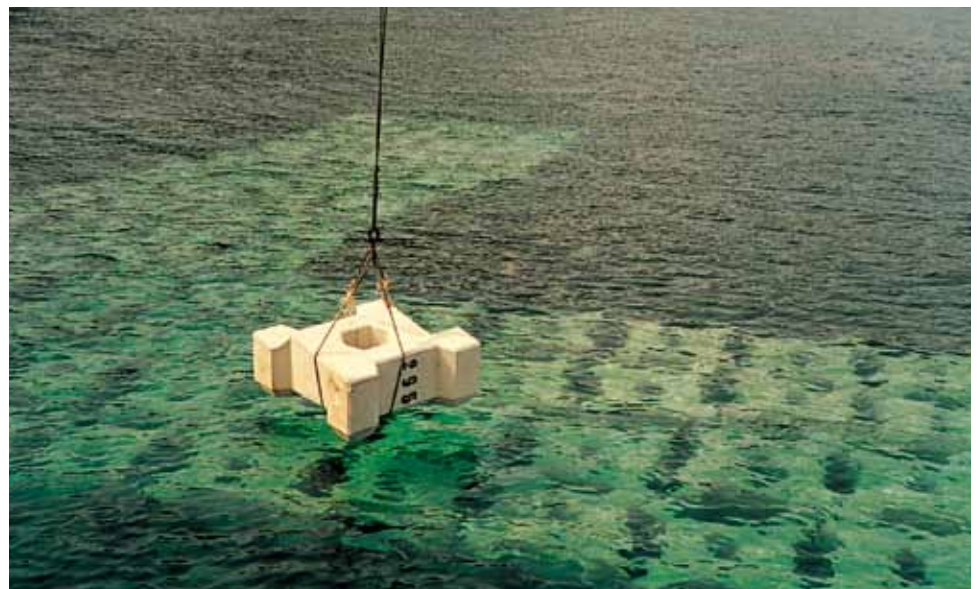
人工リーフ工法 石川県珠洲土木事務所 珠洲西海海岸侵食対策工事 サーフブロック2TON型
