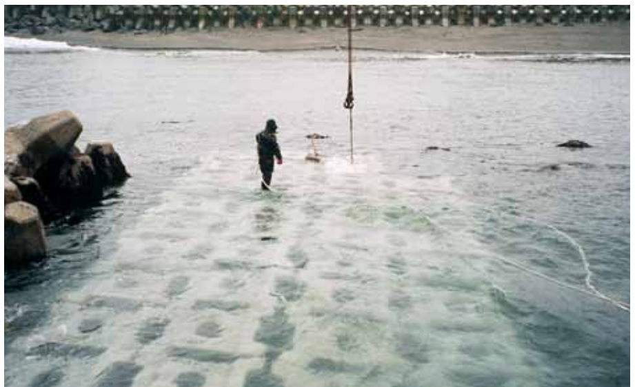
被覆工根固工 北海道白老町 白老港海岸保全施設離岸堤新設工事 サーフブロック2TON型
