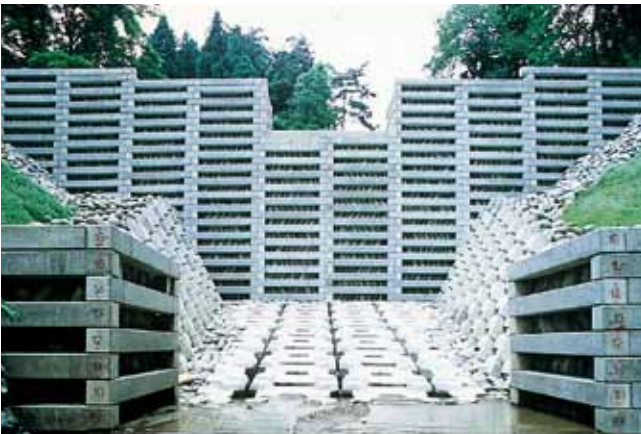
根固工 富山県入善土木事務所 黒部川支川西船合谷地すべり対策工事 サーフブロック1TON型
