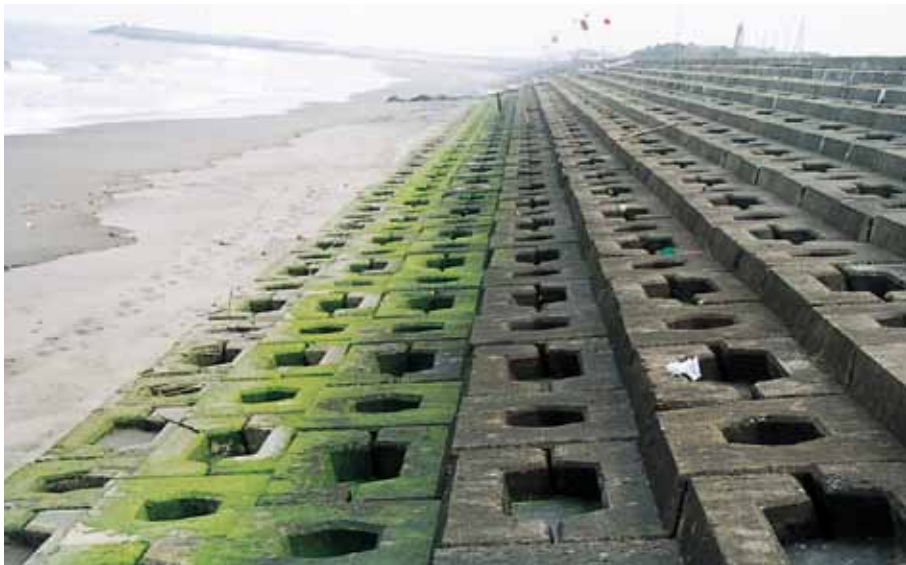
緩傾斜護岸 千葉県長生土木事務所 一宮海岸災害復旧工事 サーフブロック2TON型 3割勾配にて施工
