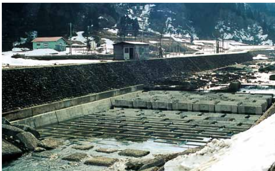
護床工 新潟県糸魚川土木事務所 名立川河川工作物関連応急対策工事 サーフブロック6TON型
