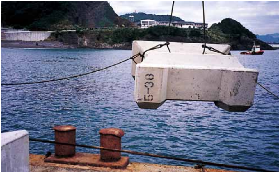
人工リーフ工法 千葉県鴨川土木事務所 浜名太海岸侵食対策工事 サーフブロック5TON, 10TON型
