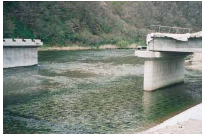
根固工 北海道開発局室蘭開発建設部 一般国道336号様似町幌満橋下部工事 サーフブロック2TON型
