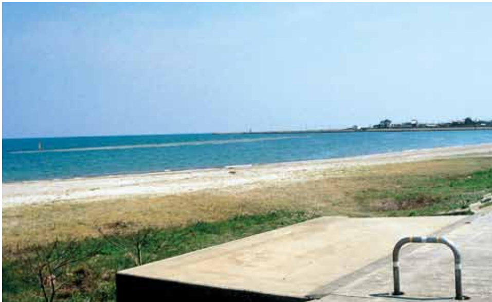
人工リーフ工法 大分県国東土木事務所 富来港海岸保全（高潮対策）工事 サーフブロック3TON型
