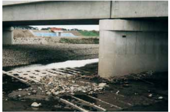
護床工 北海道開発局函館開発建設部 一般国道5号八雲町野田追道路改良工事 サーフブロック2TON型
