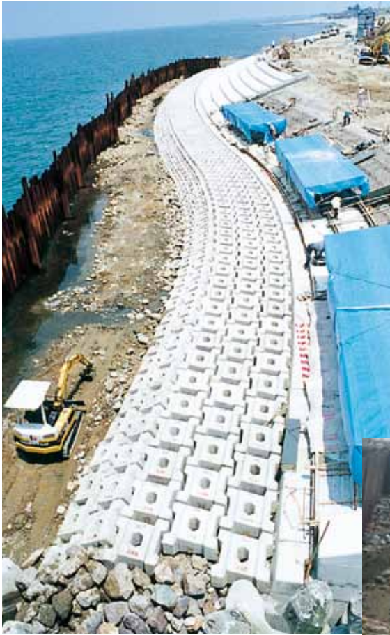
根固工 富山県魚津土木事務所 主要地方道魚津生地入善線 道路改良工事 サーフブロック1TON型
