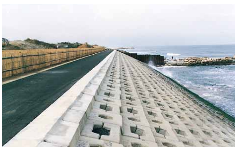
緩傾斜護岸 茨城県林業課 鹿島海岸防災林造成事業工事 サーフブロック2TON型 2割勾配にて施工
