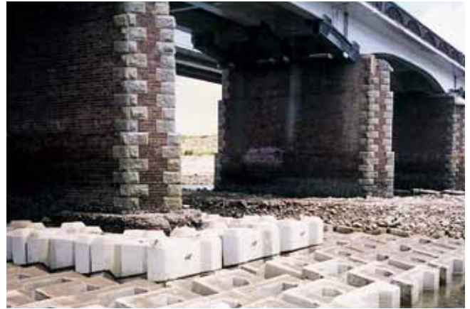
根固工 大分県中津土木事務所 山国橋橋脚根固工事 サーフブロック4TON型
