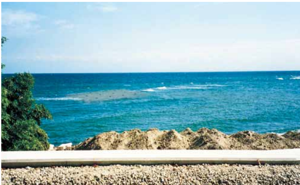
人工リーフ工法 石川県七尾土木事務所 庵海岸環境整備工事 サーフブロック2TON型
