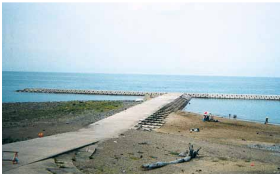
T型突堤工法 島根県益田土木建築事務所 持石海岸環境整備工事 サーフブロック6TON型
