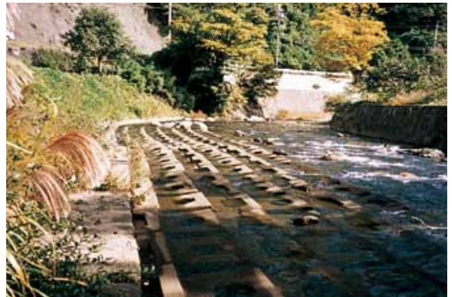
根固工 福井県敦賀土木事務所 耳川災害復旧工事 サーフブロック4TON型
