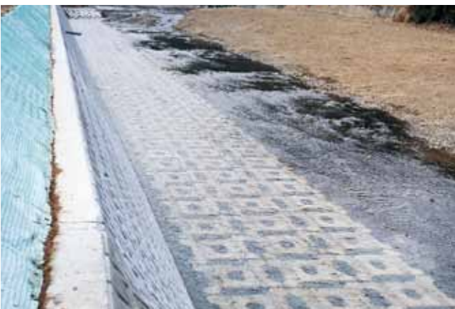
根固工 大分県臼杵土木事務所 臼杵川災害復旧工事 サーフブロック2TON型
