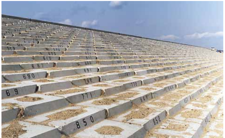
緩傾斜護岸 三重県楠町役場 海岸保全施設整備（高潮）事業工事 サーフブロック2TON型 4割勾配にて施工
