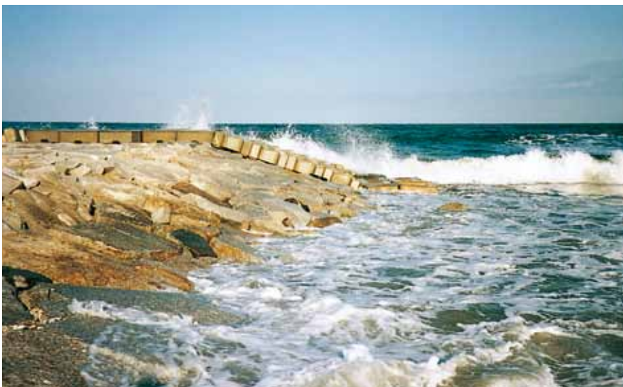
被覆工（ヘッドランド） 茨城県潮来土木事務所 鹿島海岸侵食対策工事 サーフブロック2TON型
