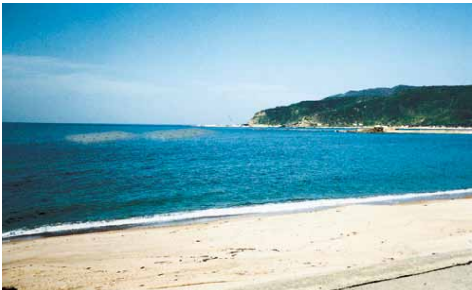
人工リーフ工法 石川県輪島土木事務所 門前海岸浸食対策工事 サーフブロック2TON型
