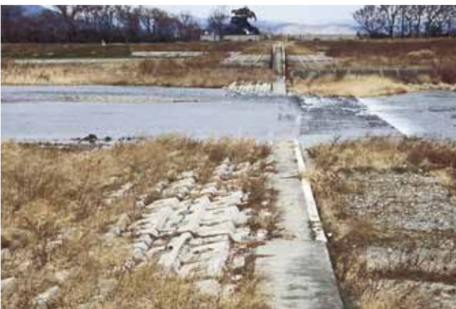
護床工 建設省木曾川上流工事事務所 牧田川応急対策工事 サーフブロック3TON型
