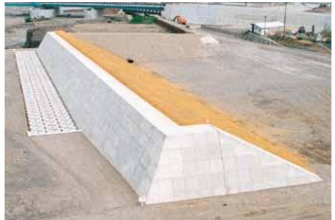
導流工堤工法 国土交通省雲仙復興工事事務所 水無川右岸導流堤工事 サーフブロック3TON型
